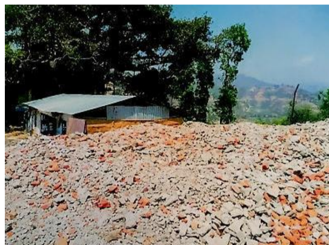
Komplett zerstört: So sehen auch heute noch, zwei Jahre nach dem großen Erdbeben in Nepal, viele Klassenräume aus.
